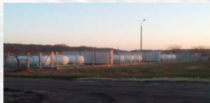
WP Krąplewice – instalacja zbiorników na gaz płynny
