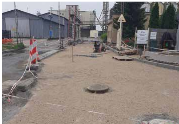
Kraplewice-inwestycja modernizacji dróg w trakcie
